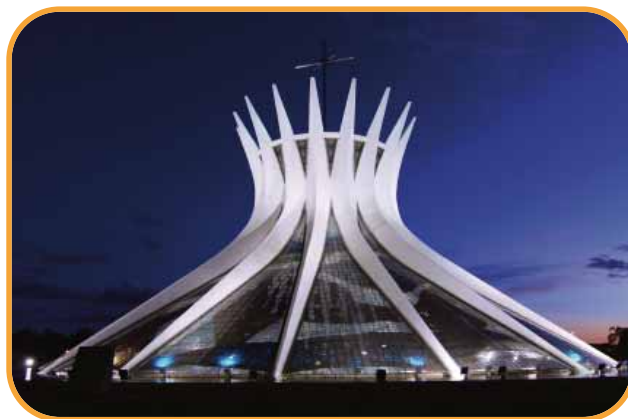
СОВРЕМЕННОЕ ЦЕРКОВНОЕ ЗДАНИЕ
